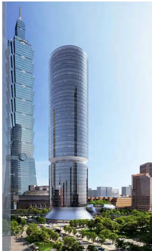
實績：南山 A21 綠環塔大樓電氣工程
