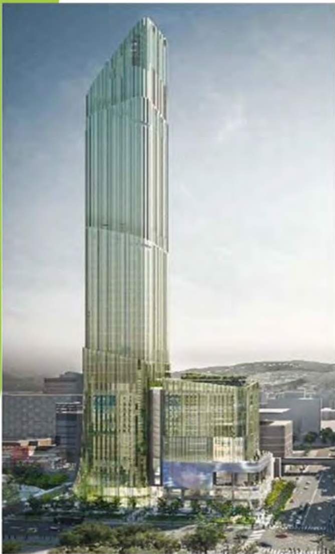
實績：TAIPEI SKY TOWER商業大樓MEP工程
